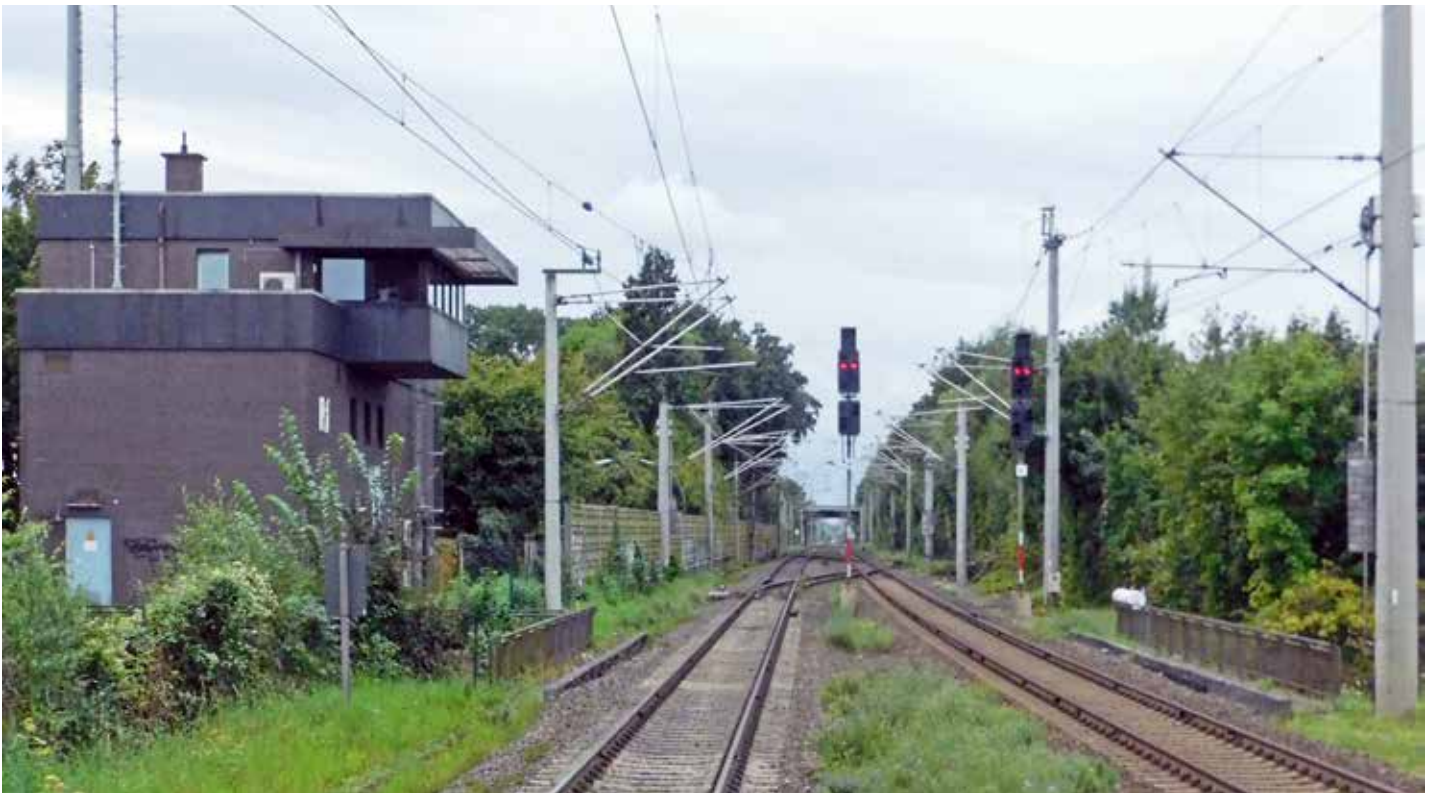
Bild 2 Rahlstedt Bahnsteig Südende: Die Entfernung vom Standort bis zur Brücke im Hintergrund beträgt 560 Meter
