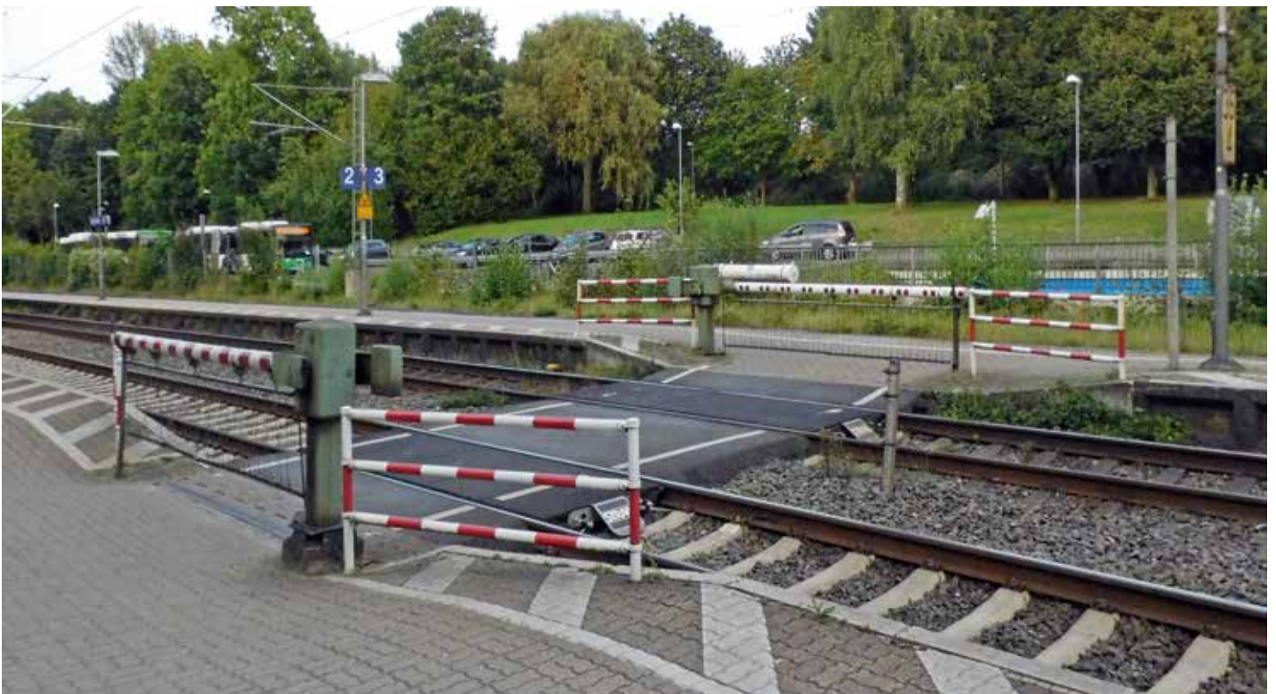
Bild 8 Der Mittelbahnsteig ist nur durch Querung der Gleise 1 und 2 zu erreichen, die Schranke wird manuell gesteuert
