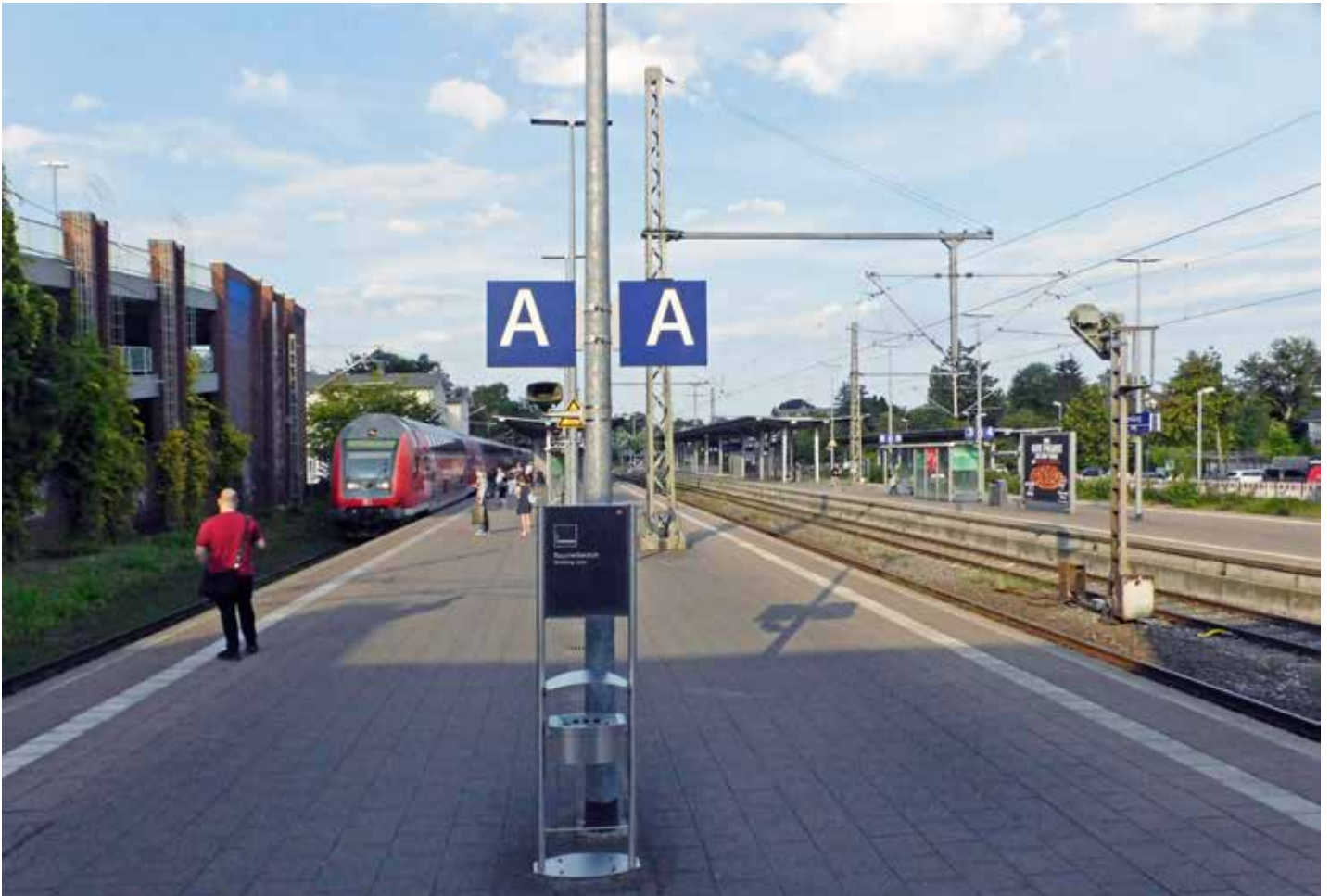
Bild 4 4 Bahnsteiggleise und 1 Durchfahrtsgleis, Blick Richtung Lübeck auf den Bahnsteig der geplanten S4
