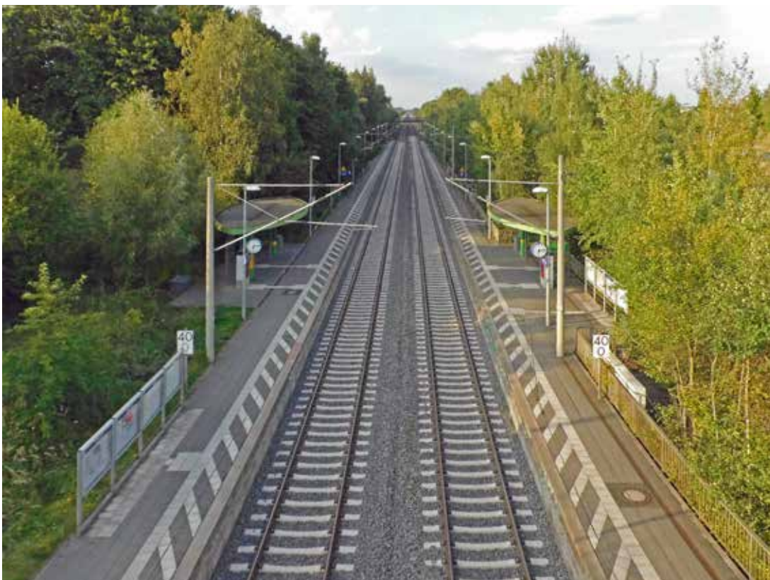
Bild 6 Haltepunkt Ahrensburg-Gartenholz mit Seitenbahnsteigen
