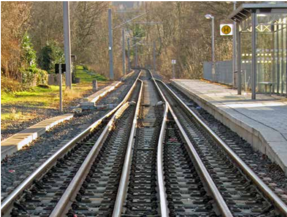
Bild 9 Gleisverschlingung zum Heranführen von Personenzügen an Bahnsteige
