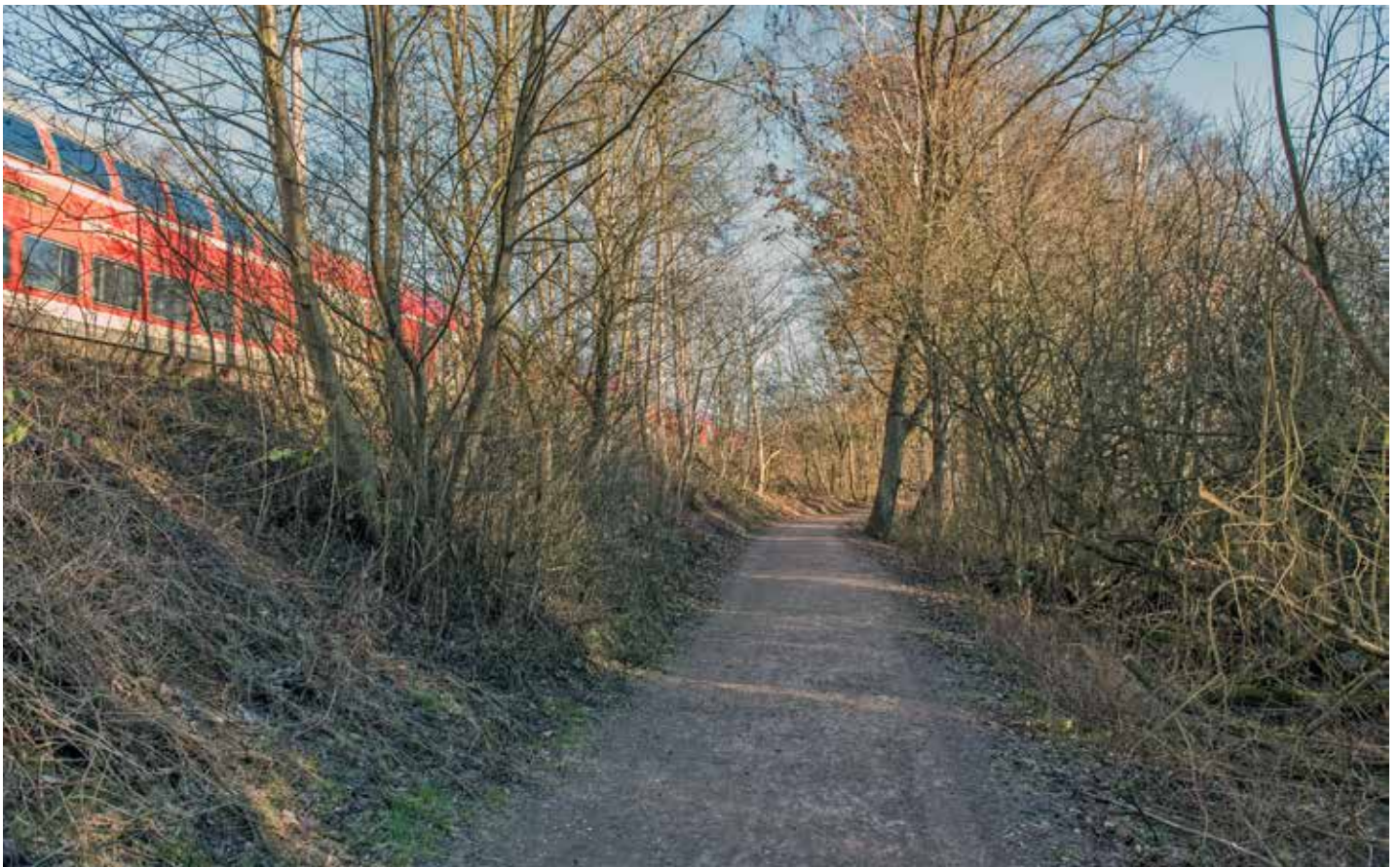
Bild 3 Für die S4-Planung der DB müsste der Bahndamm zulasten des Tunnelnals um 12,5 bis 25 Meter verbreitert werden
