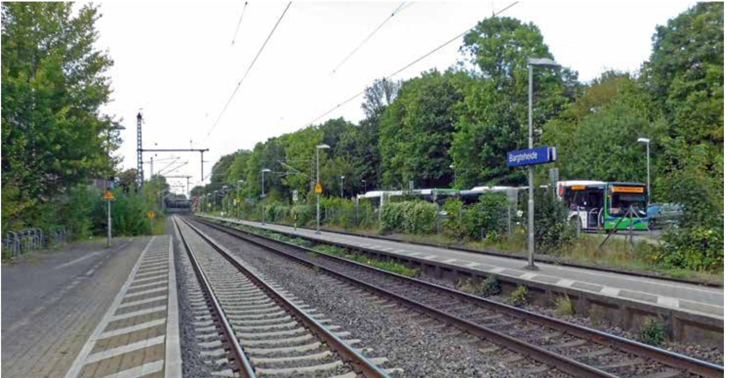
Bild 7 Bahnhof Bargteheide: Links der Hausbahnsteig und rechts der nur vier Meter breite Mittelbahnsteig mit zwei Gleisen
