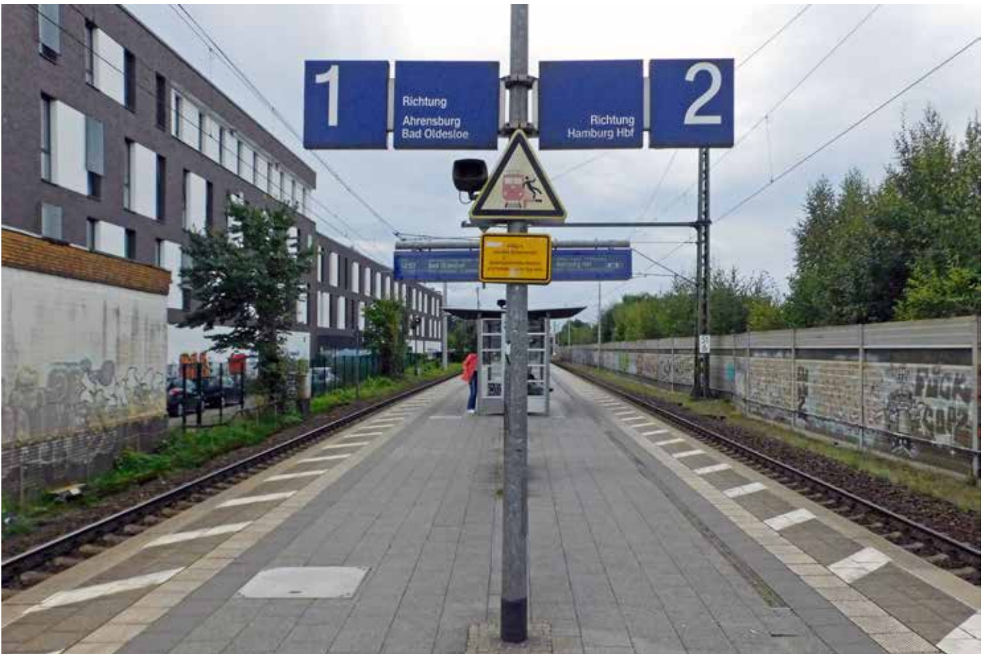
Bild 13 Blick vom Bahnsteig Rahlstedt Richtung Hamburg, links im Bild der Neubaublock auf dem alten Bahnhofsgelände
